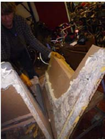
Losschroeven (/boren) + loskloppen/-trekken armleuning
